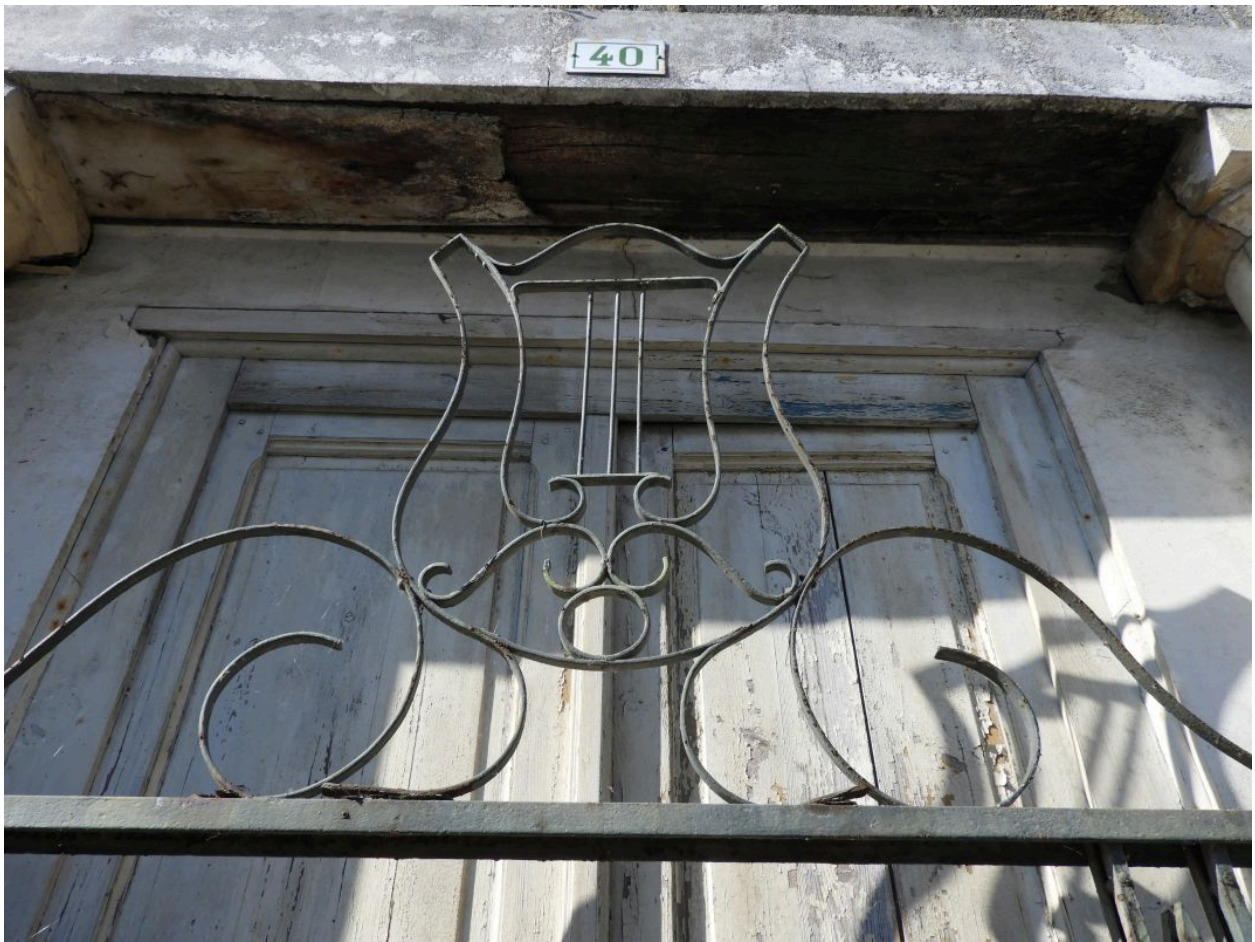
Détail du décor en ferronnerie de la façade : lyre.
