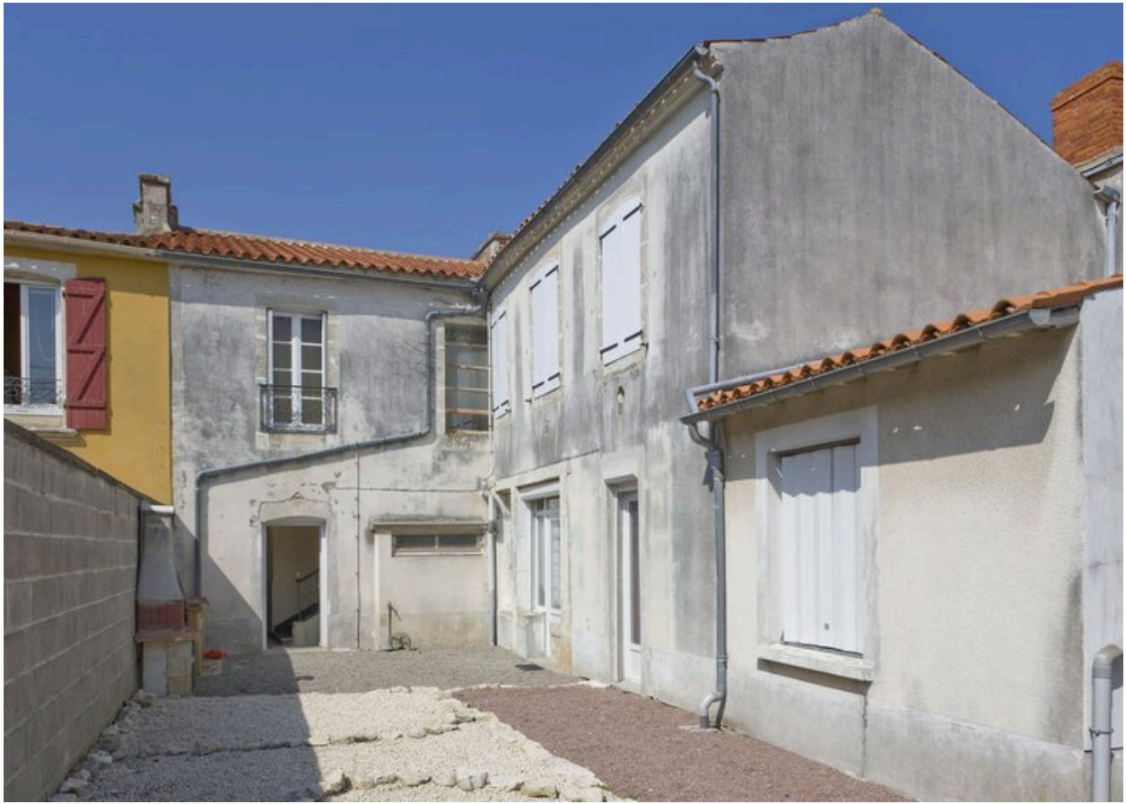
Façades sur cour de la maison (vue prise du sud).
