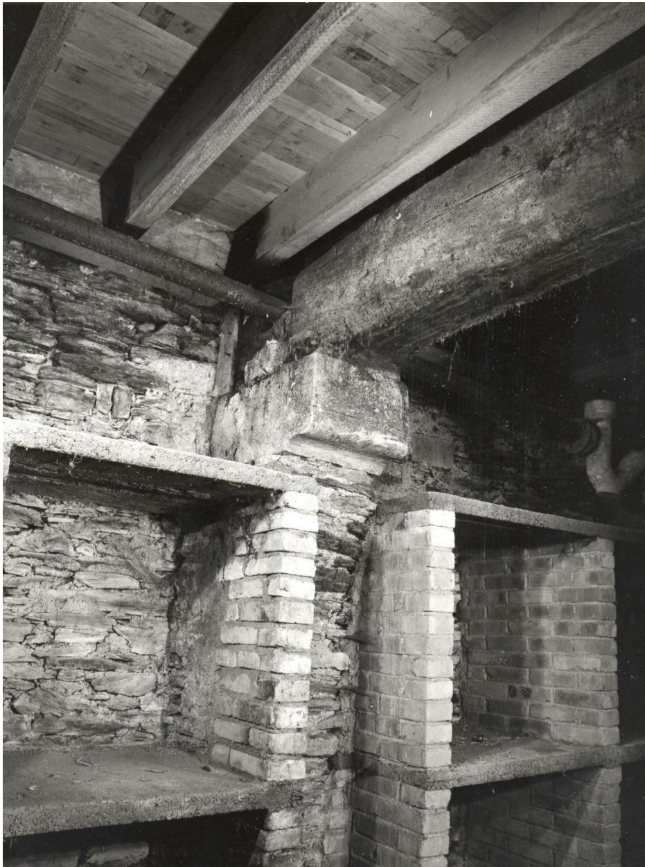
Sous-sol, cave antérieure : mur droit.
