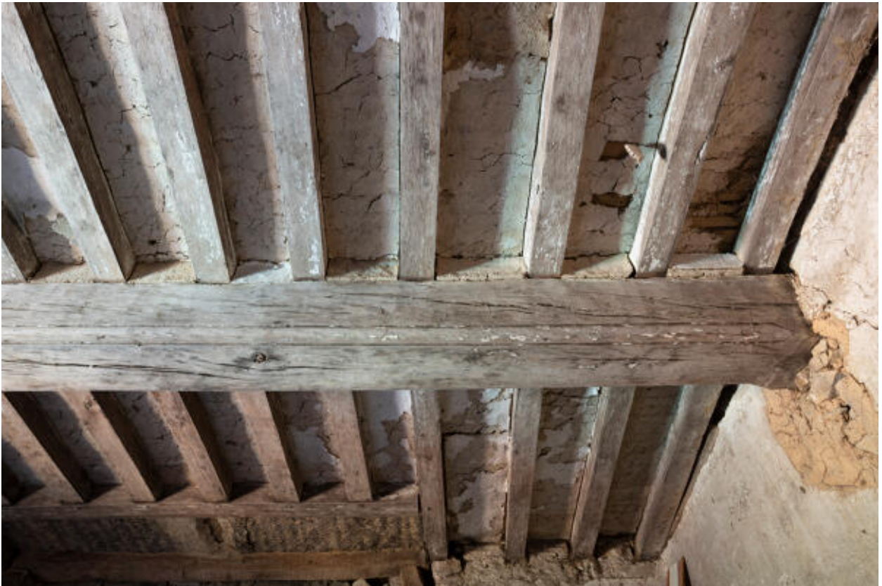
Le plafond d'une ancienne chambre.
