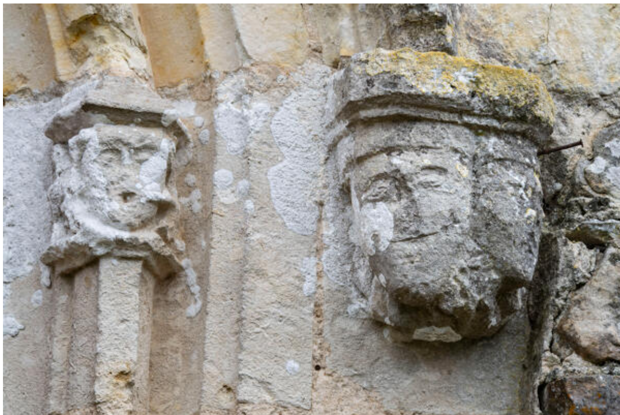
Portail occidental, chapiteaux du piédroit droit.
