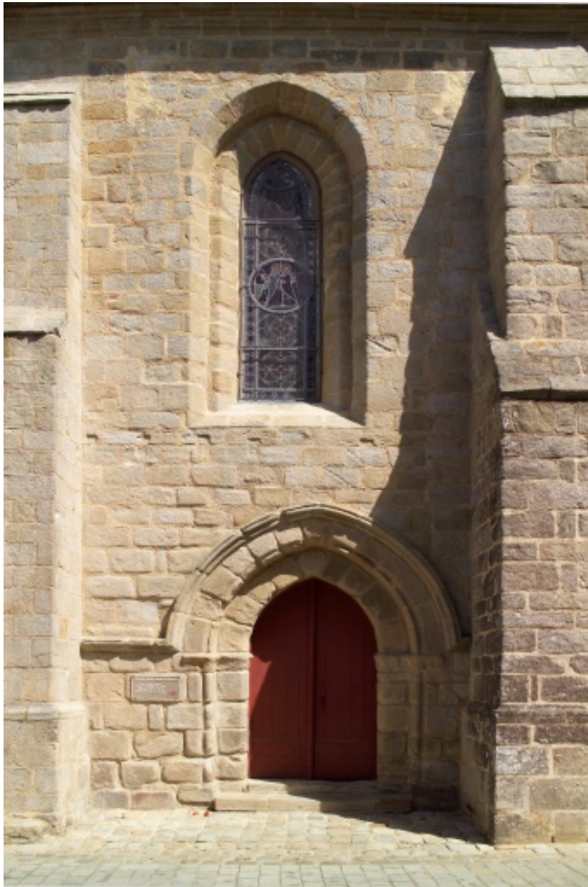
Travée centrale du mur sud : portail et baie.
