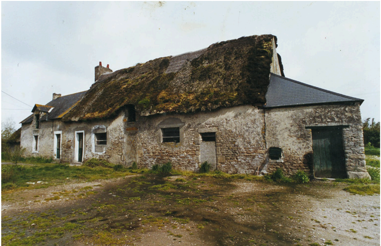
La métairie avant remaniement. Façade sud.
