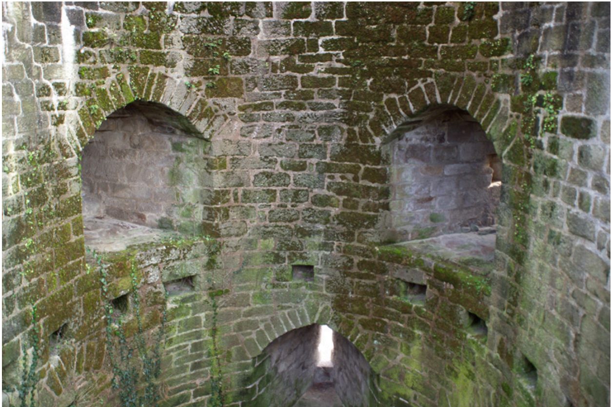
Détail des niches des ouvertures de tir.
