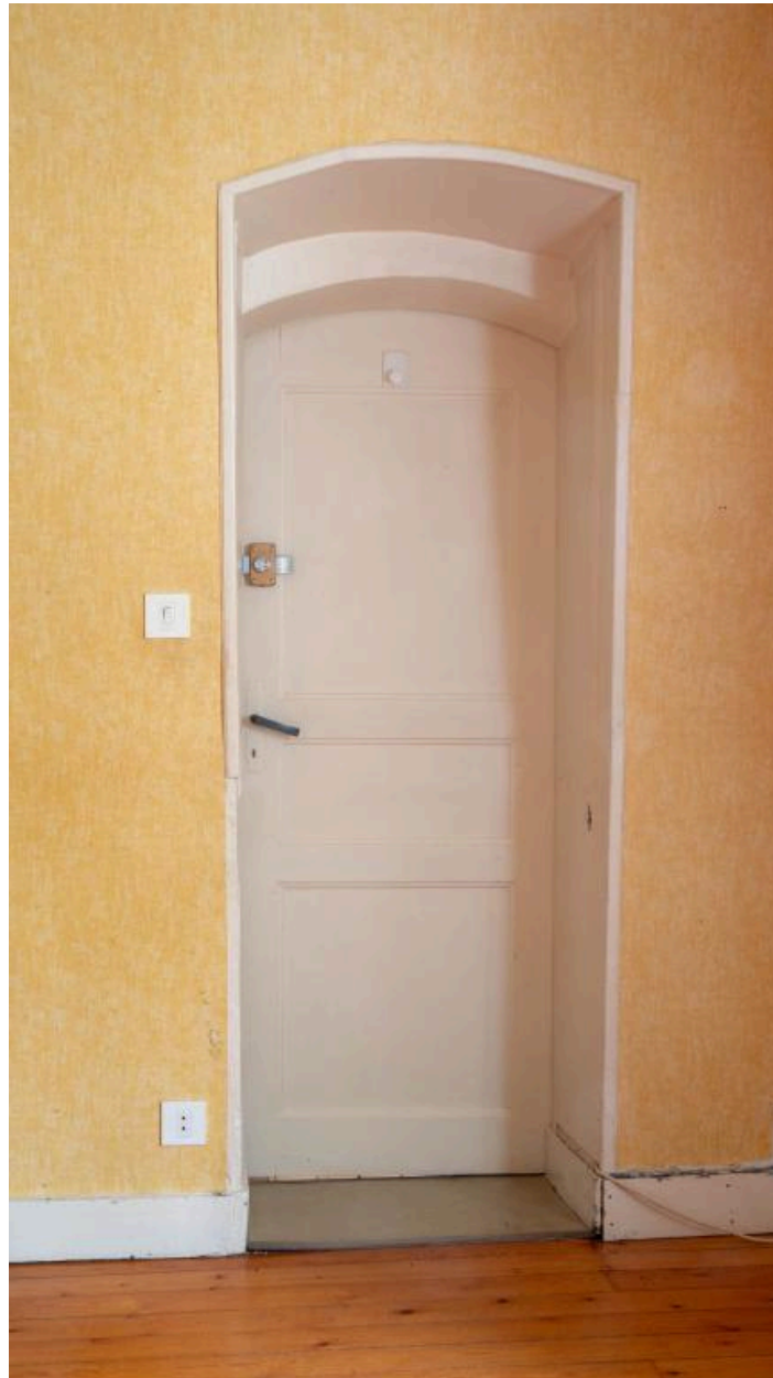
Porte de communication entre le bâtiment central et le bâtiment accolé.
