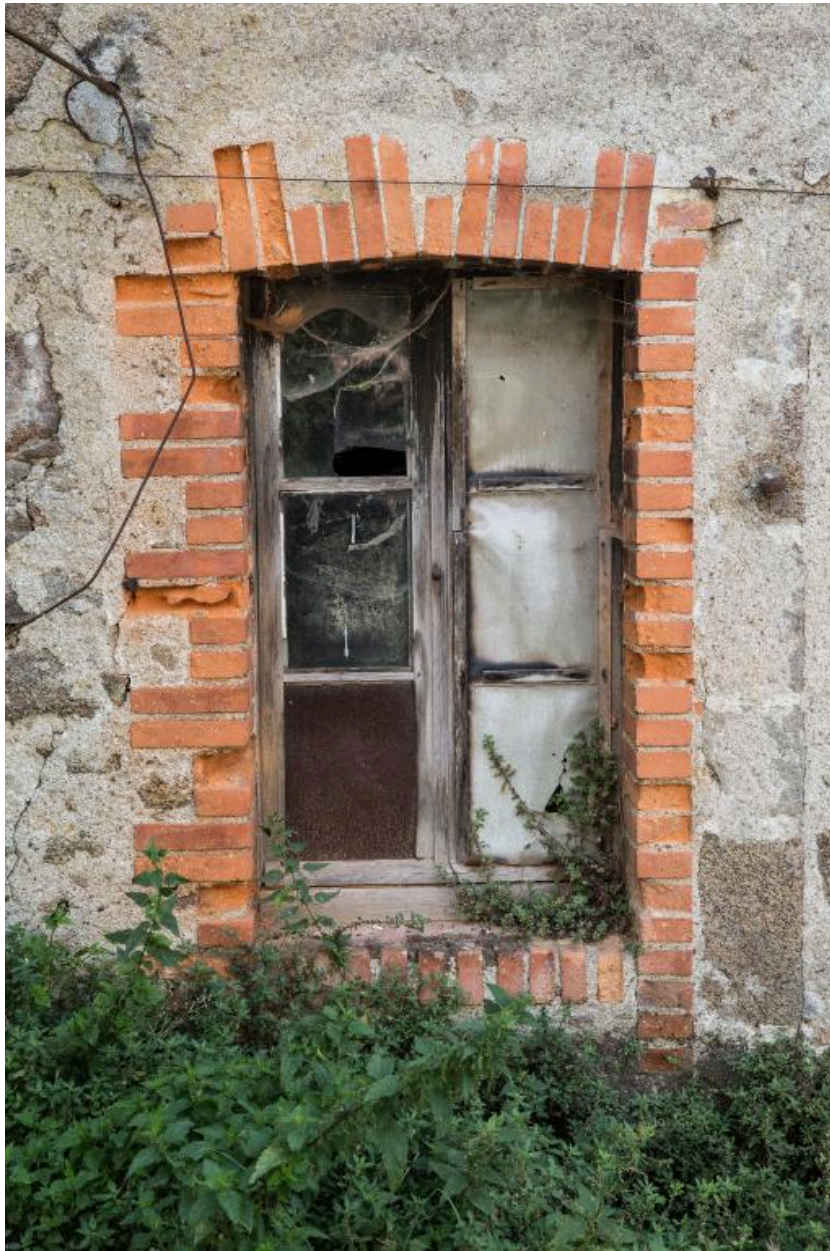
Habitation avec étage de stockage en surcroît. Détail de la baie avec encadrement en briques. Rousselin, Boussay, cadastre 2018, 000 ZW 01-126.
