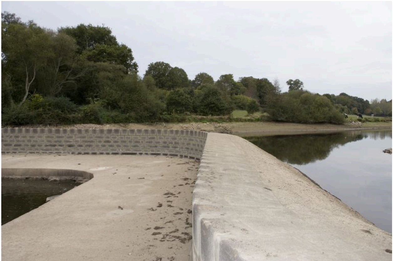
Le barrage vue depuis l'est pendant les écourues de 2009.
