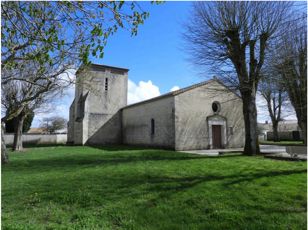
L'église vue depuis le nord-ouest, entourée par l'ancien cimetière.
