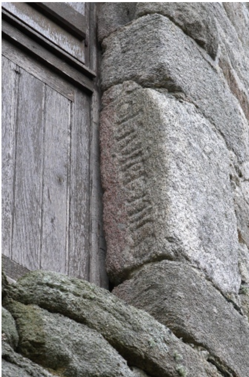
Cage, partie est, porte haute est, montant droit, partie inférieure. Détail de l'inscription : Olivier [MILD].
