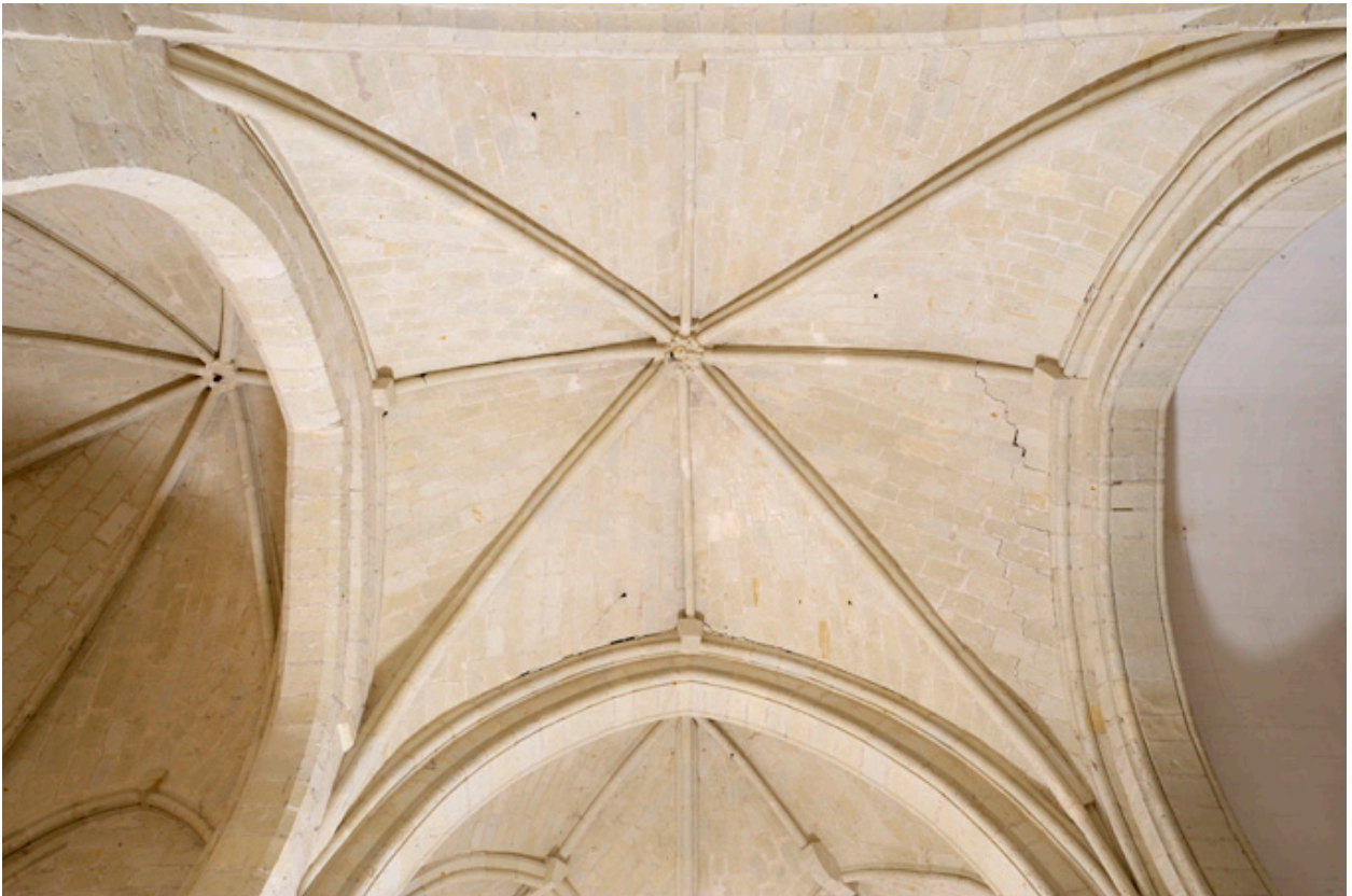
Voûte de la croisée du transept.
