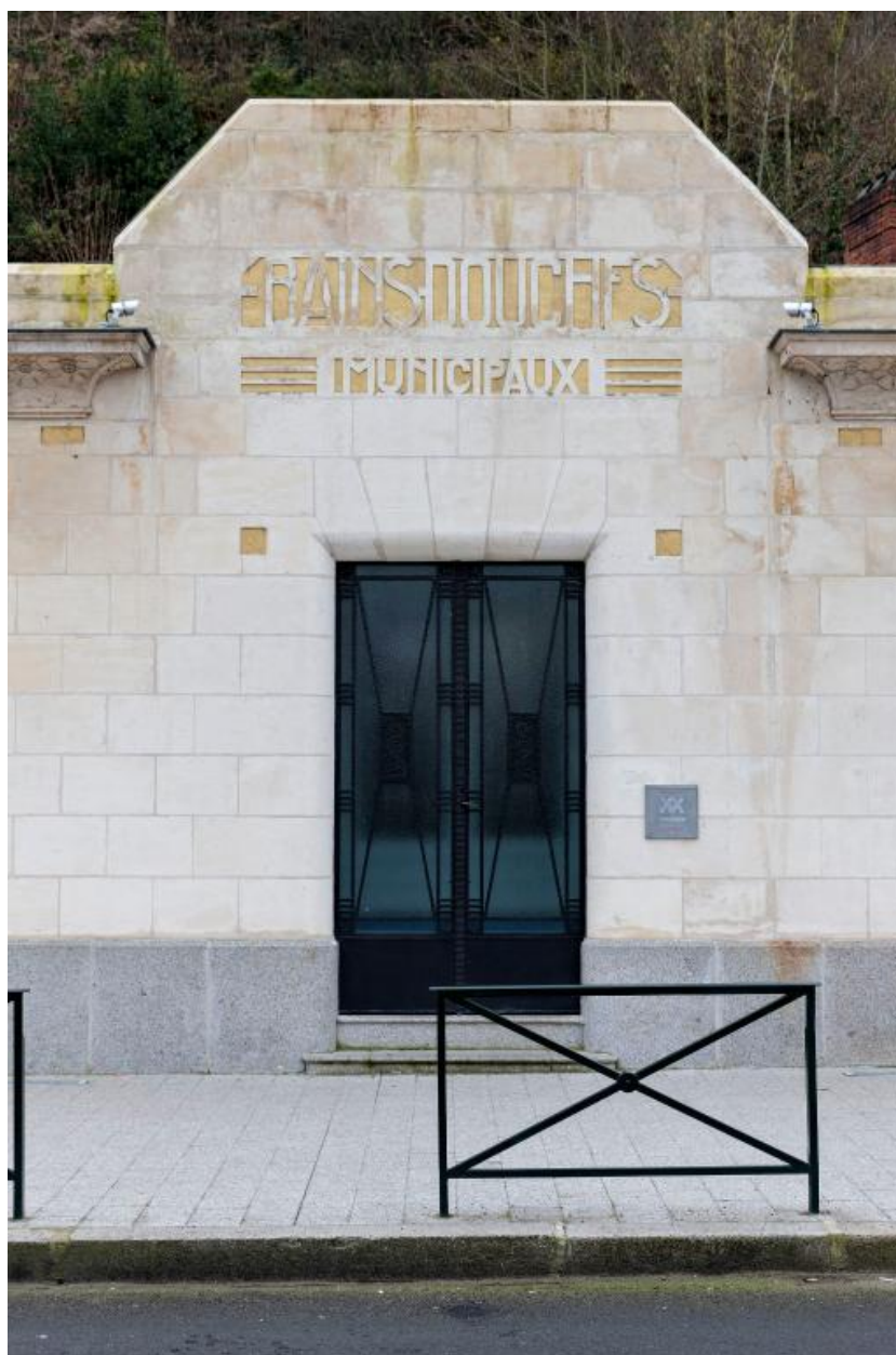
Les bains-douches restaurés. Elévation antérieure, vue de détail : porte d'entrée et fronton.
