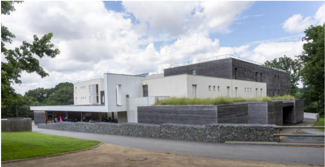
Les bâtiments du lycée.
