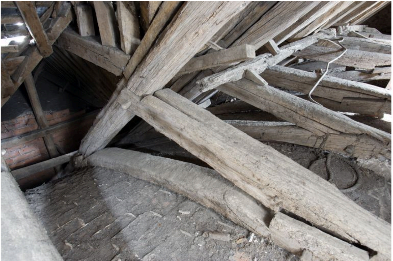
Charpente du chœur. Parties nord des premières fermes depuis l'ouest : chevrons, faux entrails et aisseliers.
