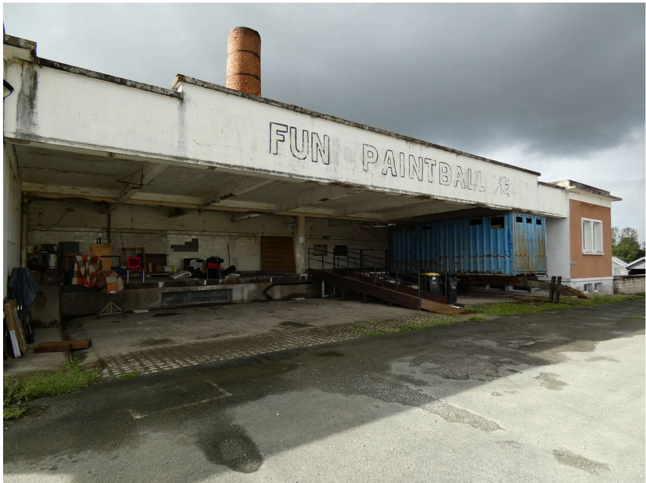
Le quai de déchargement, au nord de l'ensemble, vu depuis le nord-est.
