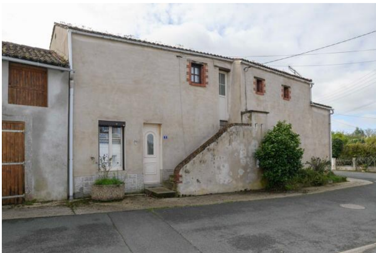
Façade nord de la maison du 3 rue de l'Airault, Saint-Laurent-du-Mottay.
