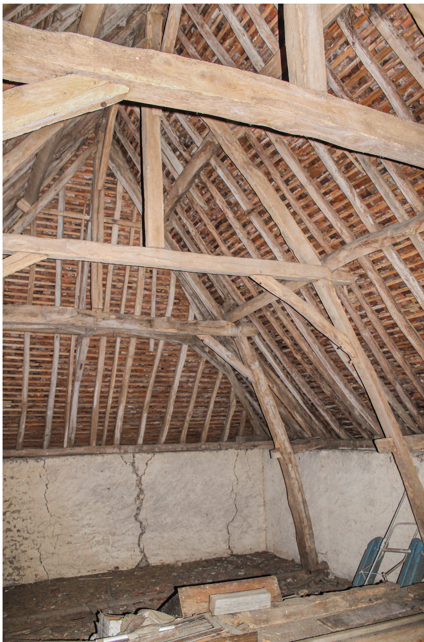
La charpente de la grange d'îmière, XVIIIe siècle.
