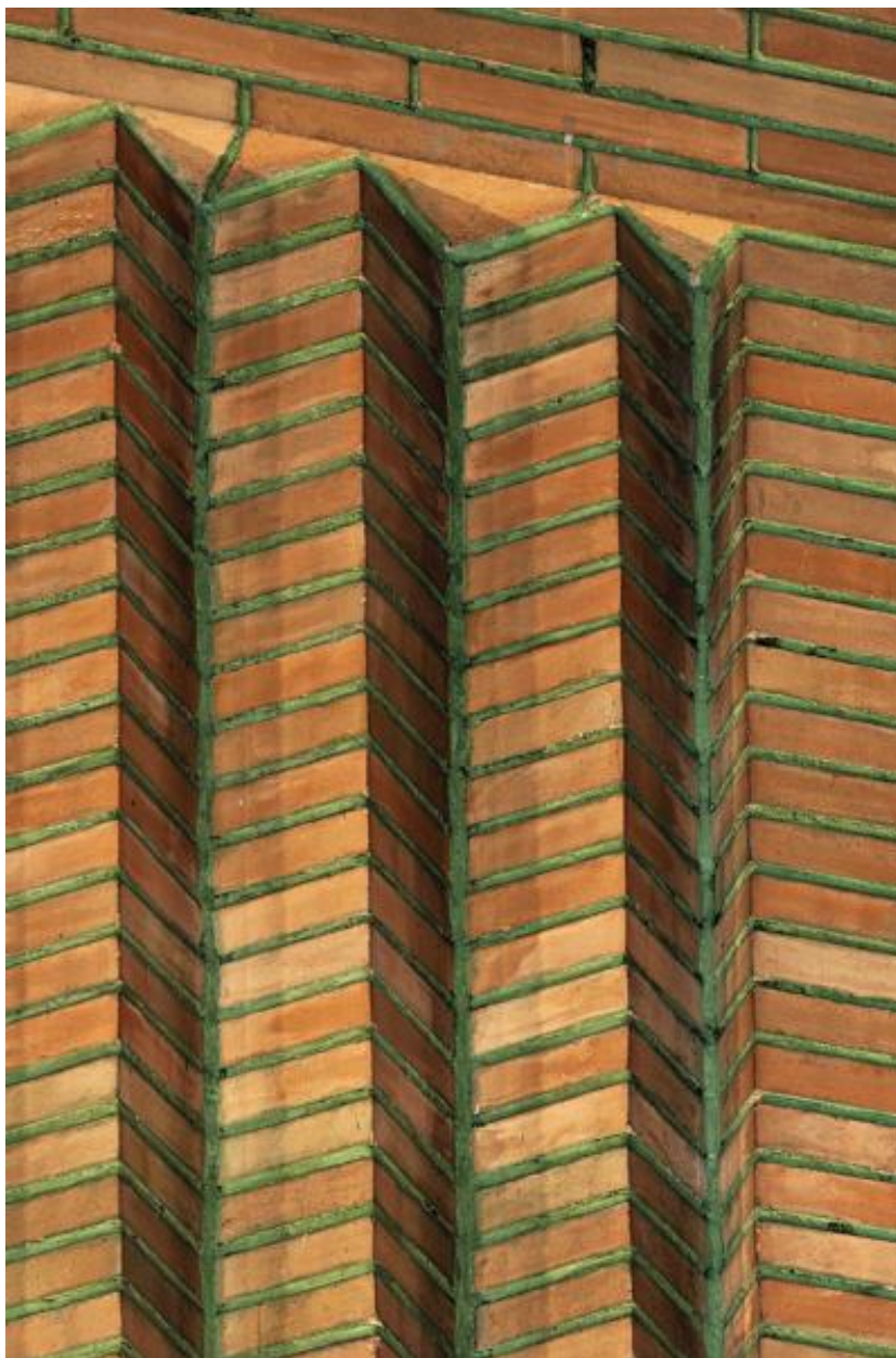
Jeux de brique en parement sur les murs de la chapelle.
