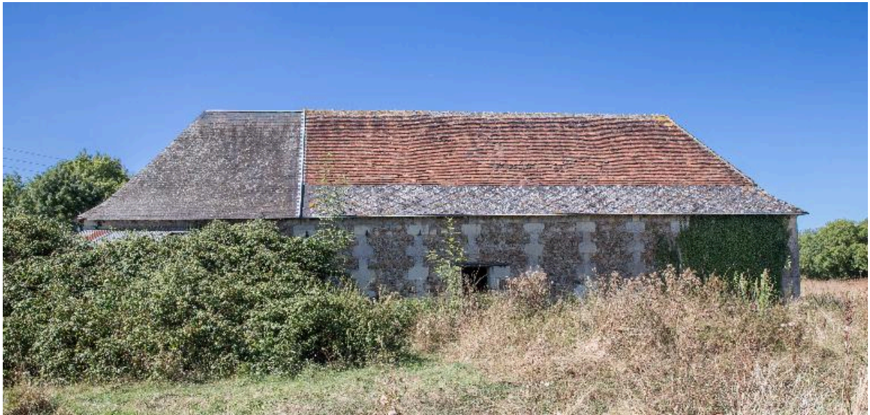
Grange-étable, façade postérieure.
