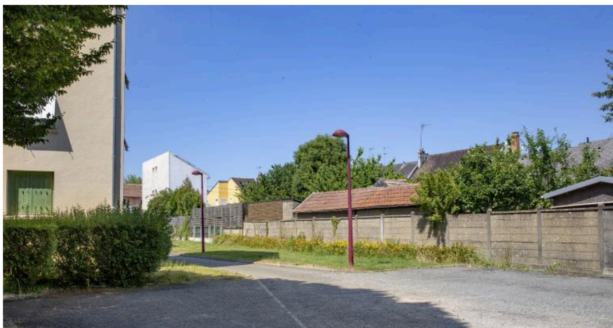
Vue du mur de clôture en béton depuis l'arrière du bâtiment D (tranche 3).
