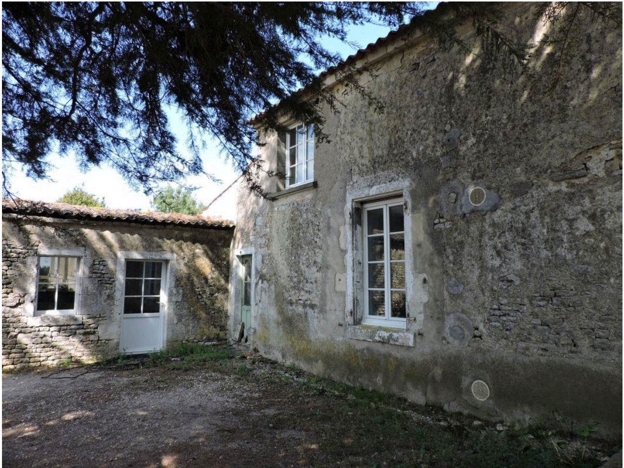
L'ancien logement au nord du logis, vu depuis le sud-ouest.
