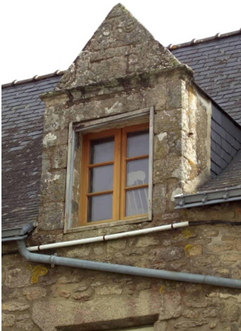
détail de lucarne du corps sud.
