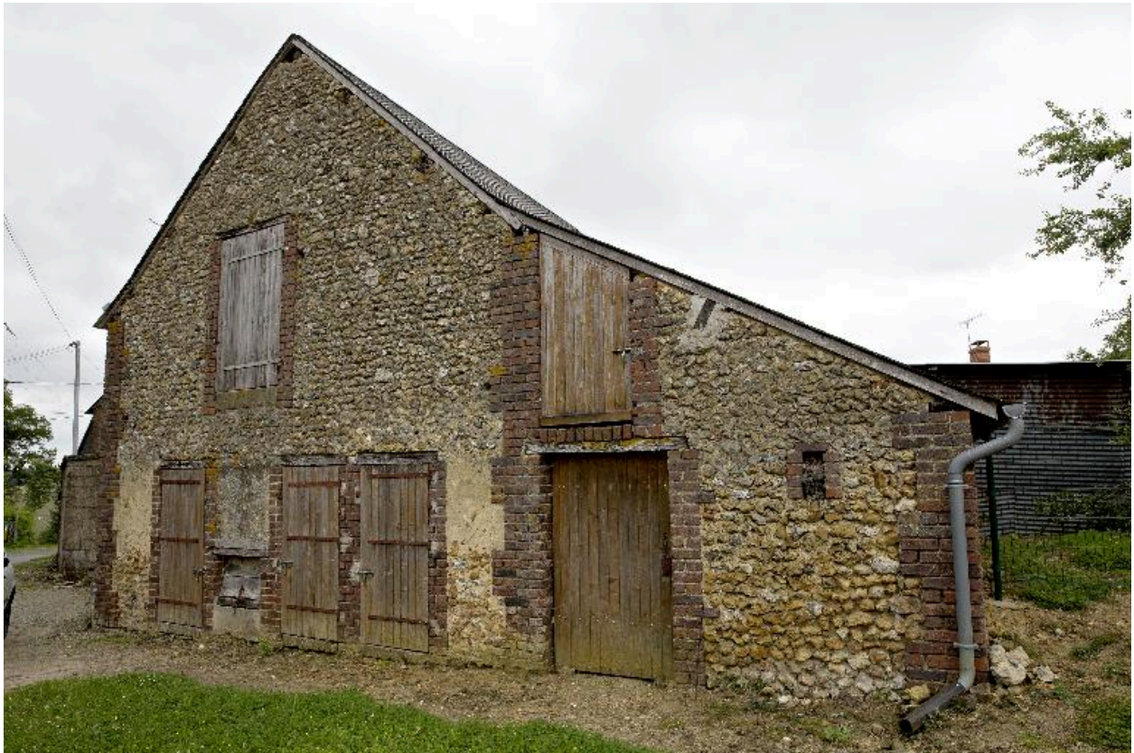
Soues en bout de la grange-étable (n°3).
