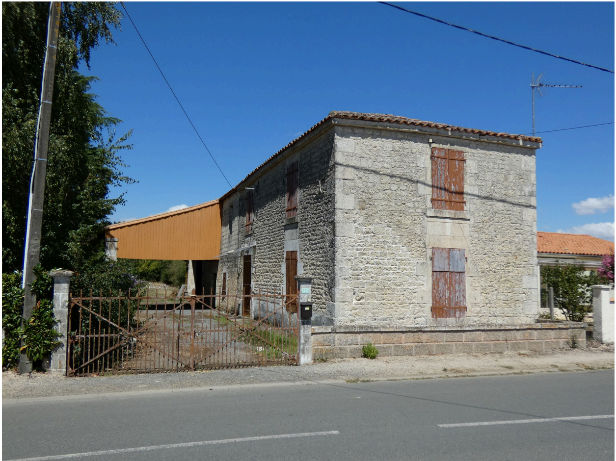
Logis de ferme à un étage, allées du Château.
