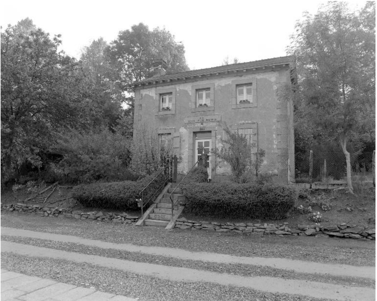
La maison éclusière.
