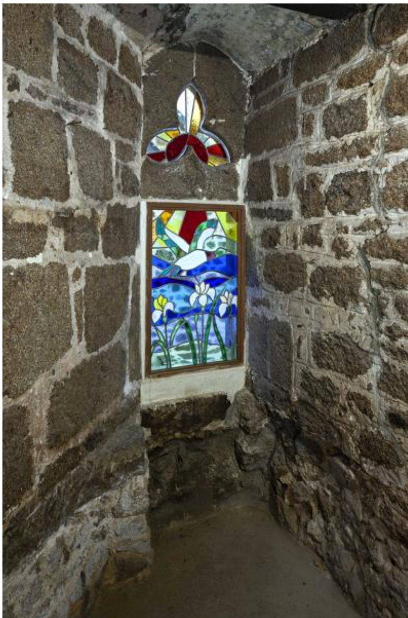
Ebrasement intérieur de la baie trilobée.
