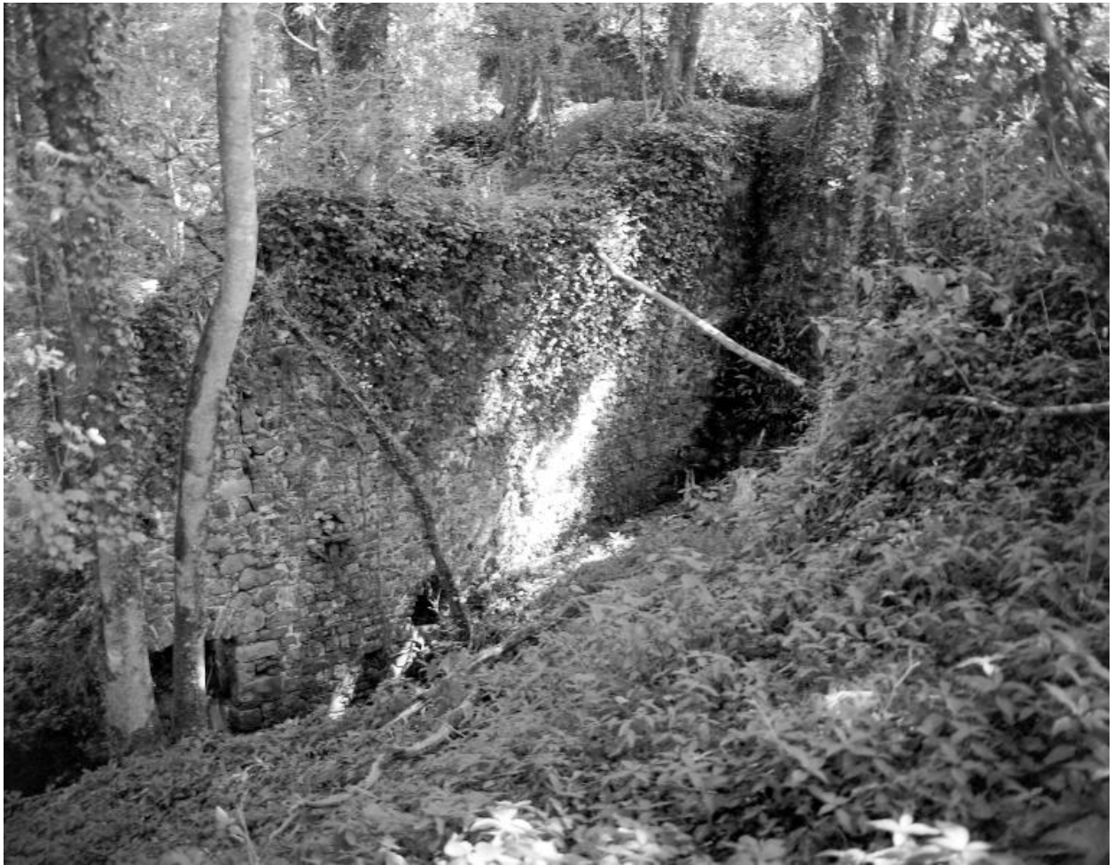
Le mur sud du haut fourneau et l'ancien passage d'eau vus depuis le sud-ouest.
