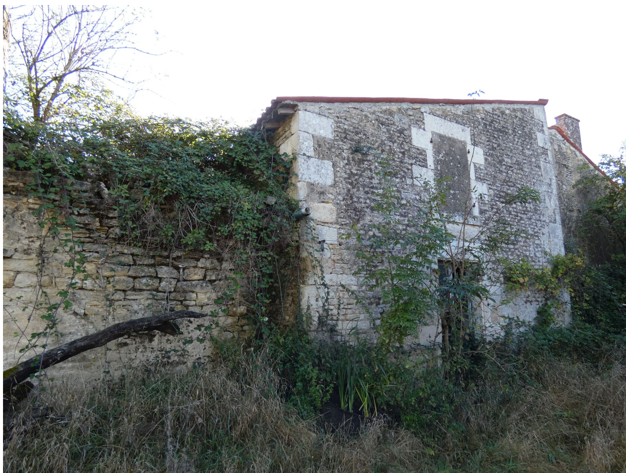
Ancienne laiterie à l'arrière du logis, vue depuis le nord.
