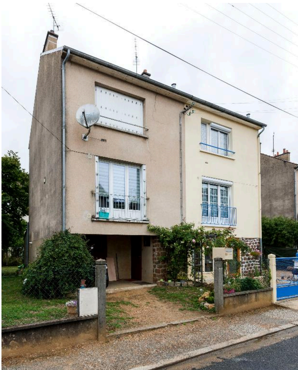
Elévation antérieure des maisons jumelles 6-8, rue du docteur Roux. A noter la porte d'entrée de la maison reportée sur le côté de la porte du garage.
