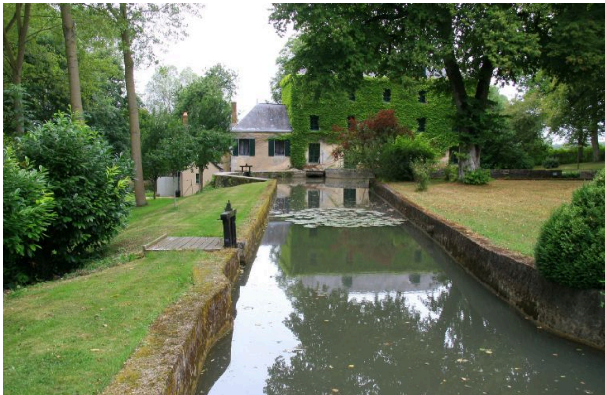
Bief avec deux pelles de déversoir.
