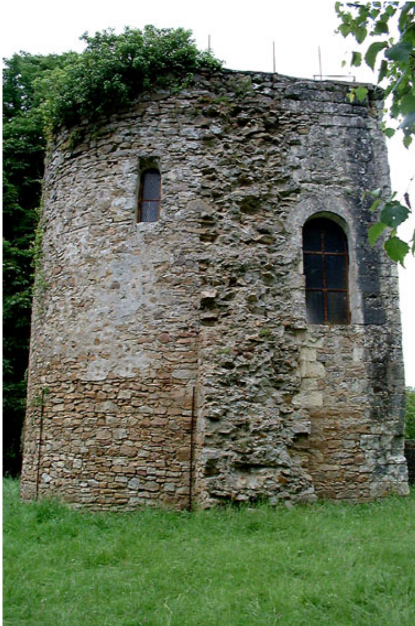
Angle sud de la tour avec arrachements de maçonneries.
