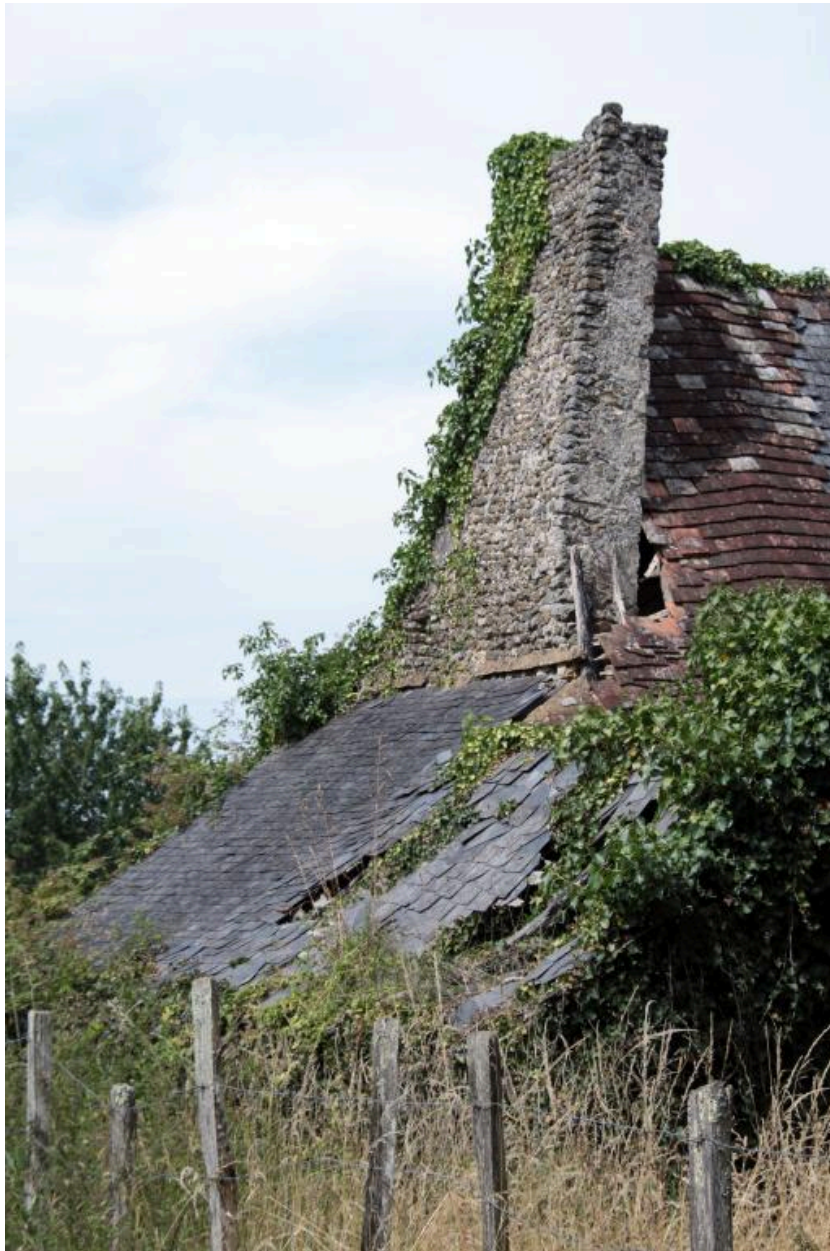
Pignon ouest : souche de cheminée et appenti du four.
