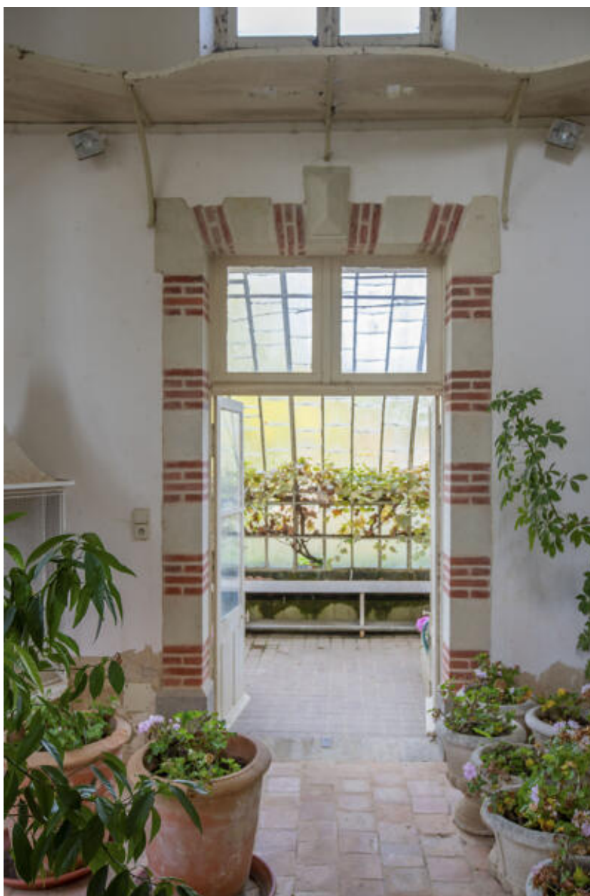
L'orangerie, porte d'accès à la serre nord.
