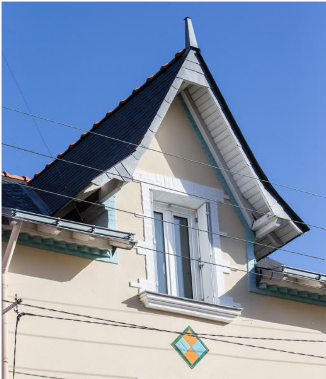
Maison, 20 quai Henri-Brunais. Détail de la lucarne.
