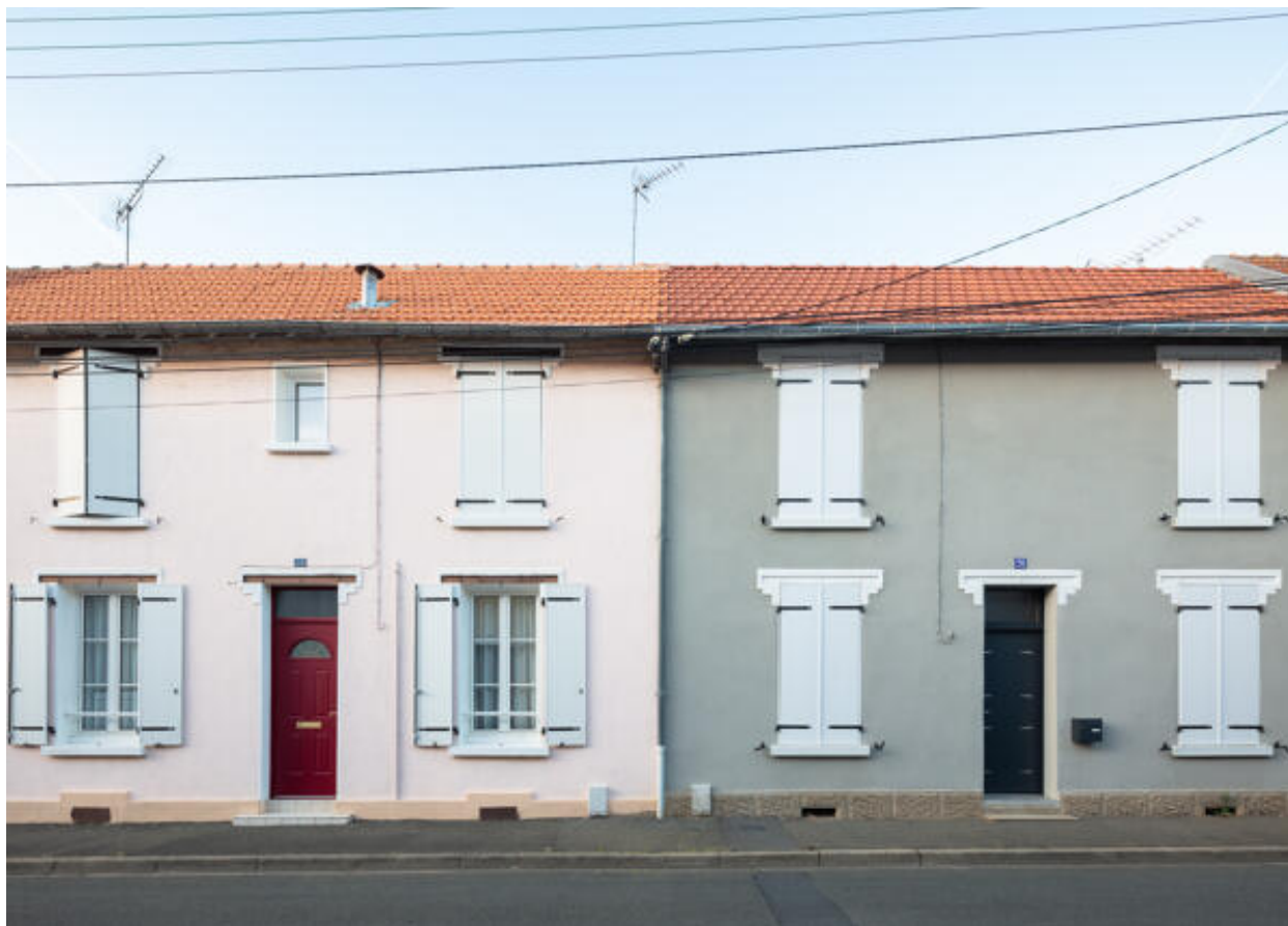
Vue de deux maisons mitoyennes rue de la collectivité.
