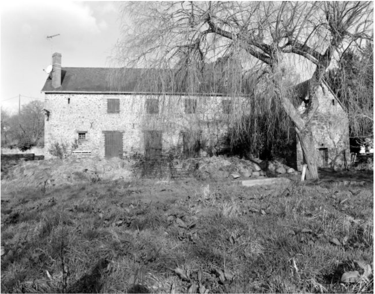
Les dépendances du moulin détruit au 19e siècle. Vue du sud-est.
