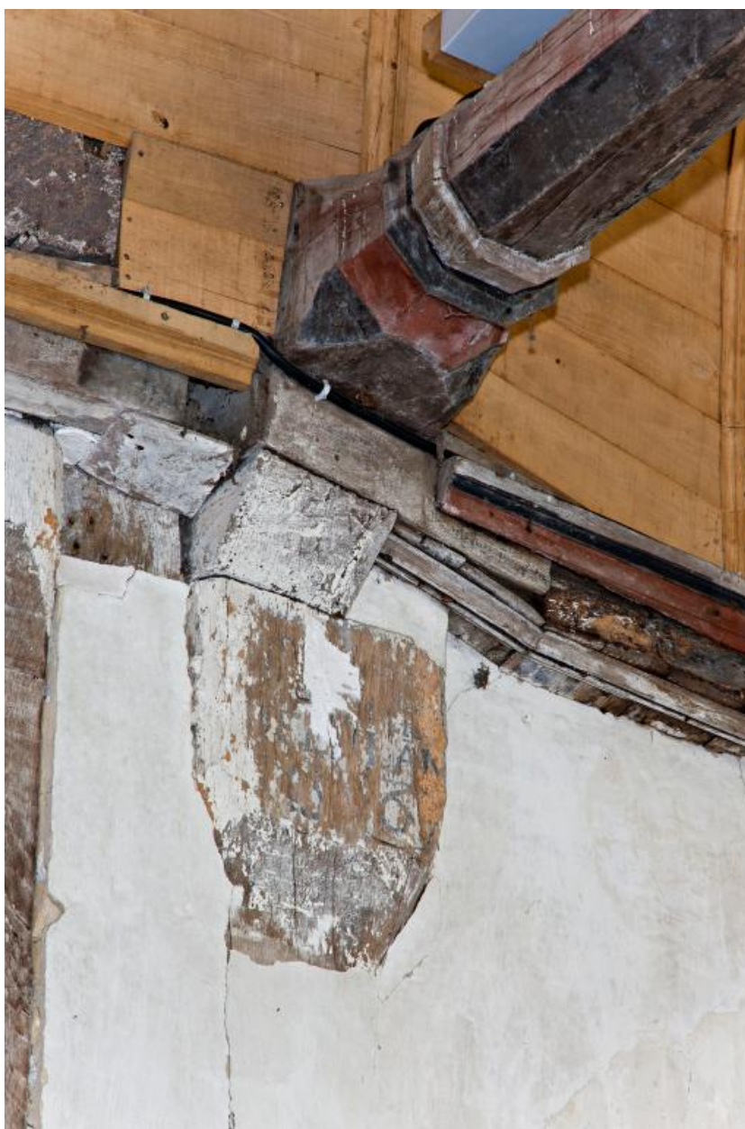
Nef, mur nord : détail d'un poteau de bois et départ d'un entrait.
