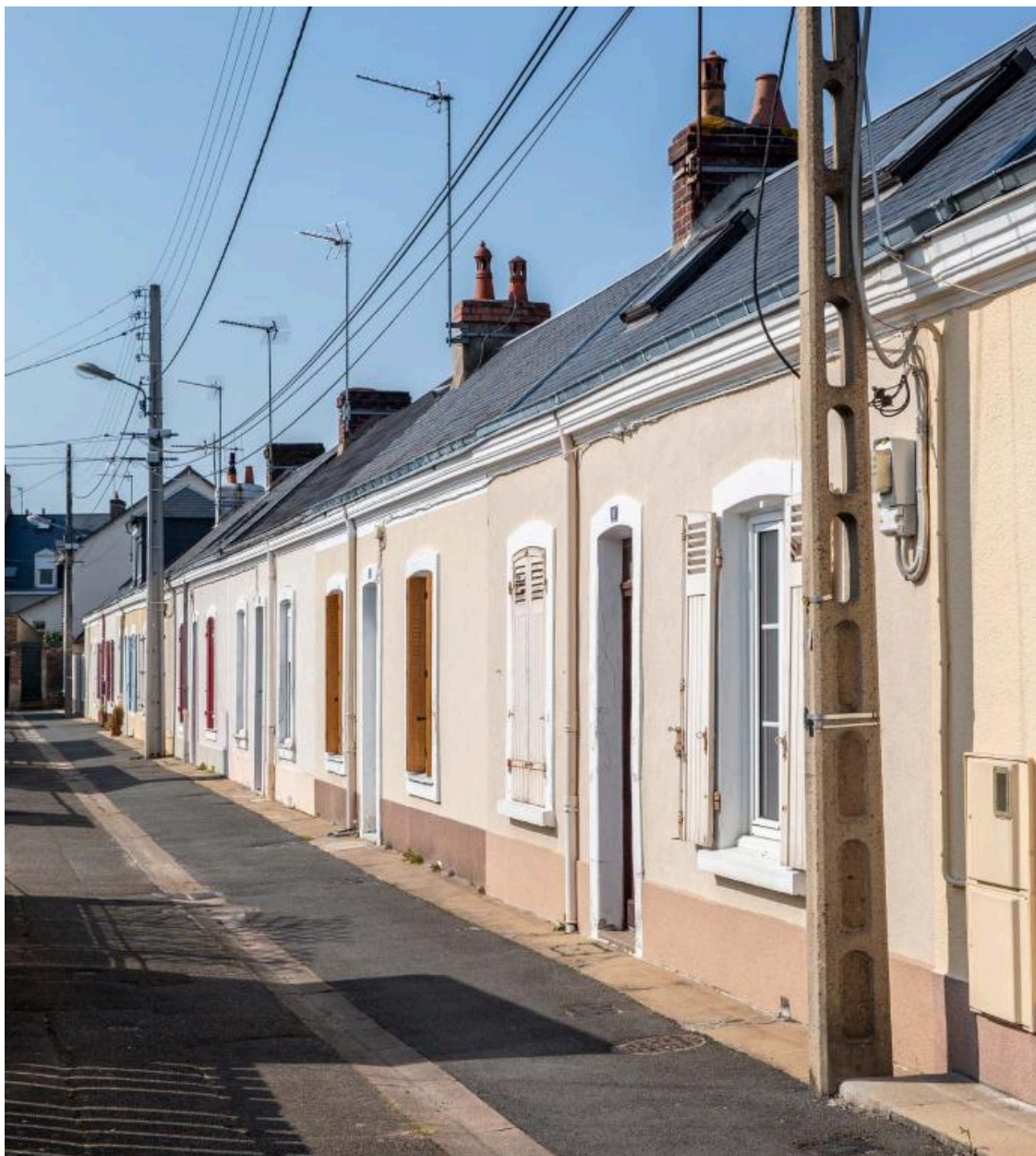
Maisons Blavette depuis l'entrée de l'impasse.
