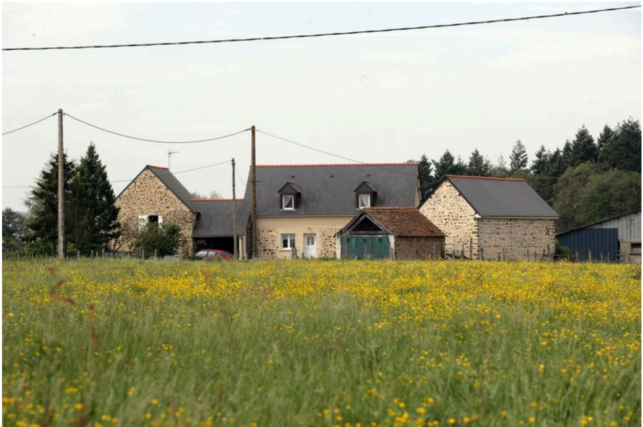
Vue d'ensemble depuis le chemin à l'est.
