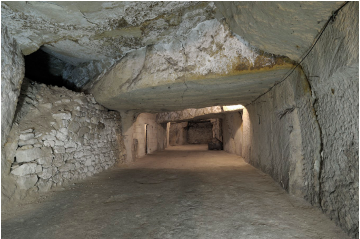
Cavité sud-est : galerie d'extraction du XIXe siècle (1).
