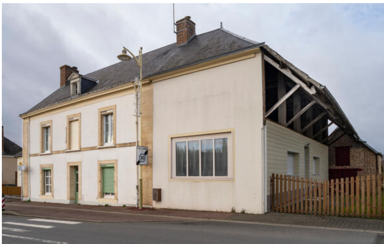
Maison, 9 rue de Saint-Calais, 2e moitié du XIXe siècle. Séchoir ajouté dans la 1ère moitié du XXe siècle.
