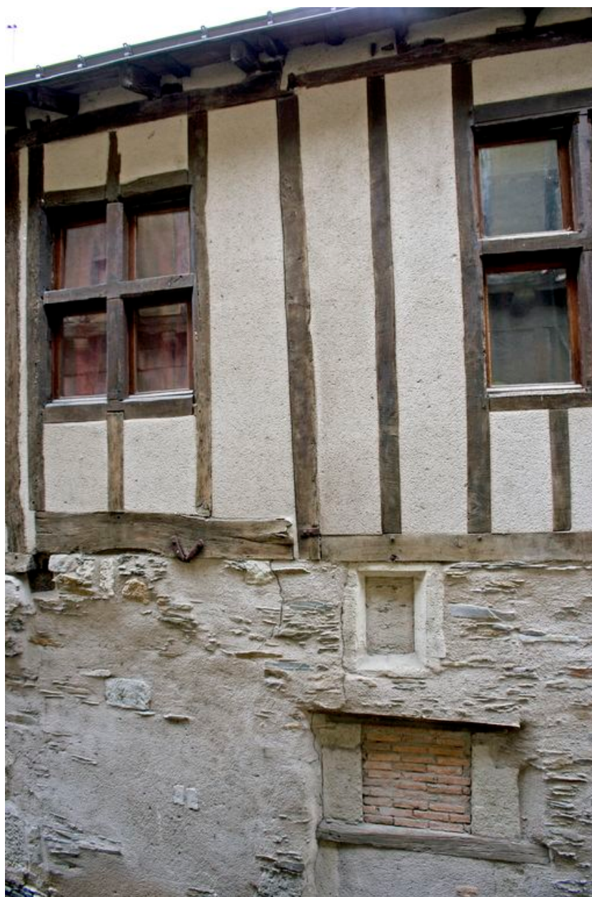
Elévation latérale gauche sur la rue Pinte, partie médiane.
