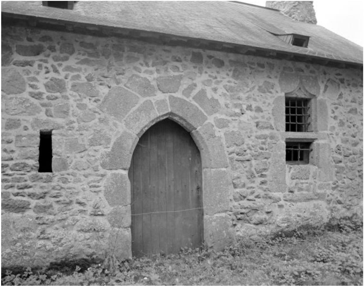
Détail de la façade principale : la porte et la fenêtre à meneau.
