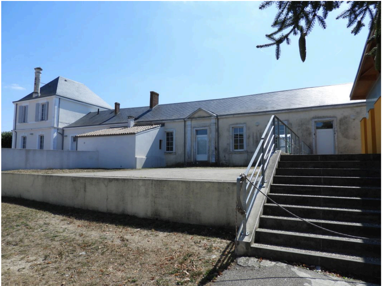
Les bâtiments vus depuis le nord.
