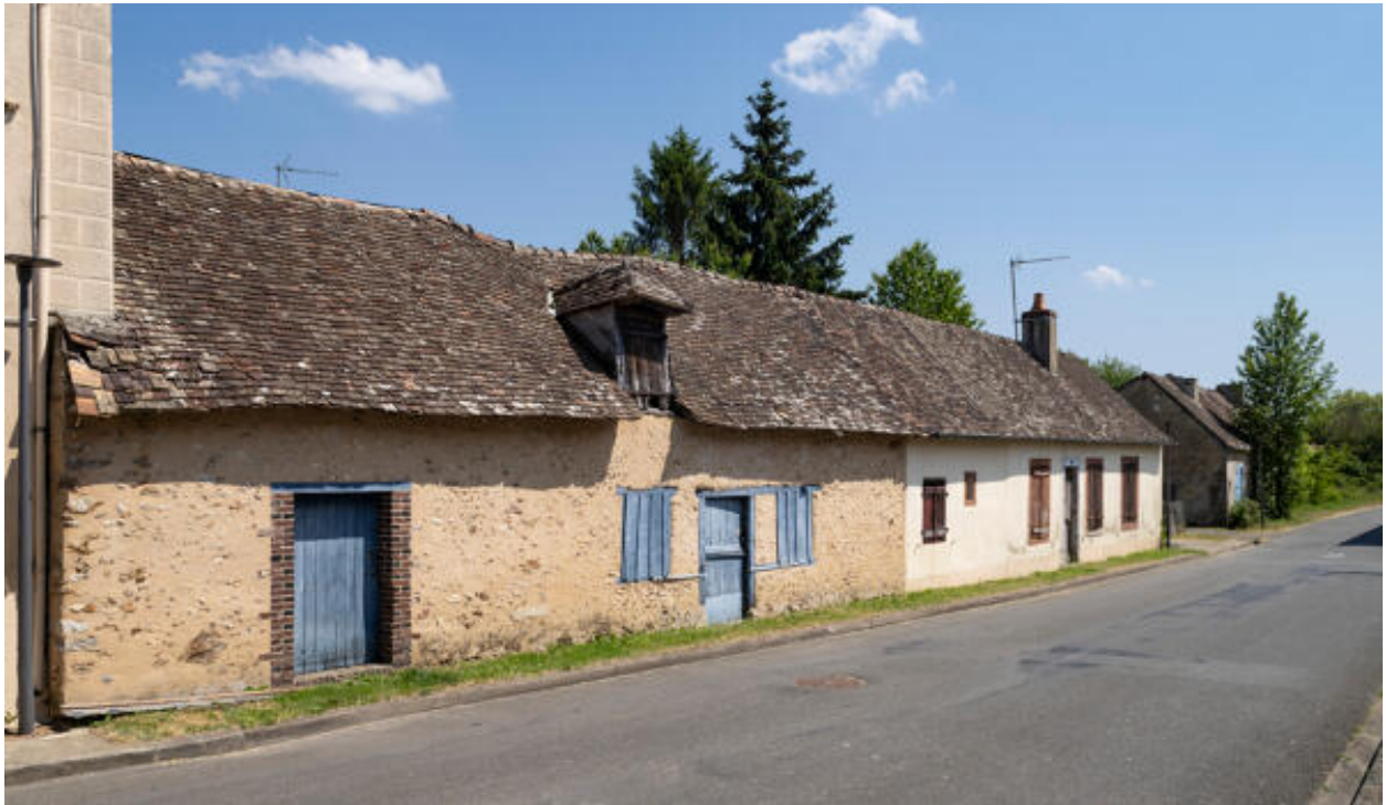
Vue de l'alignement de maisons rue de la Mairie depuis le nord.
