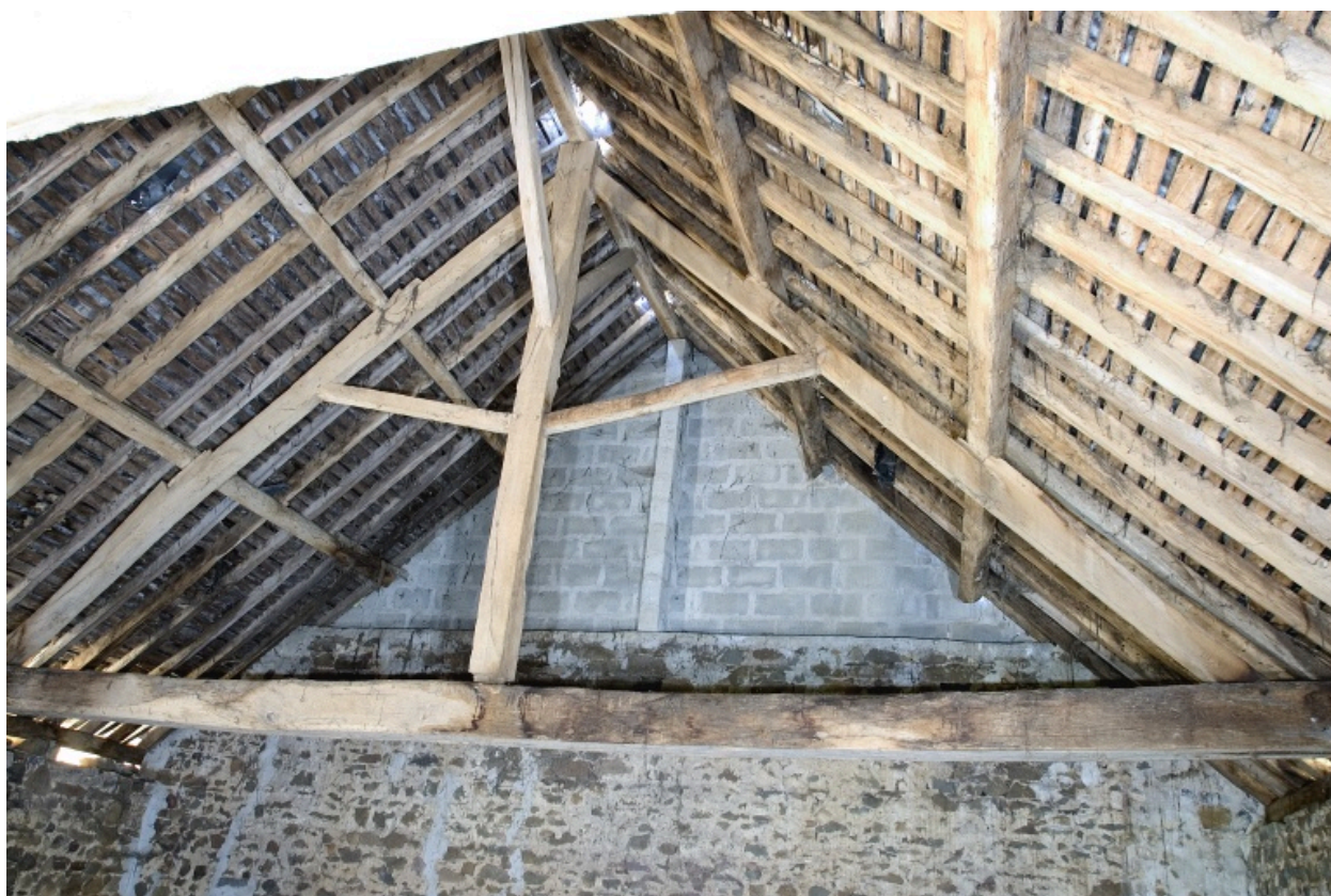
Intérieur de l'étable à vaches-grange. La charpente : ferme est.
