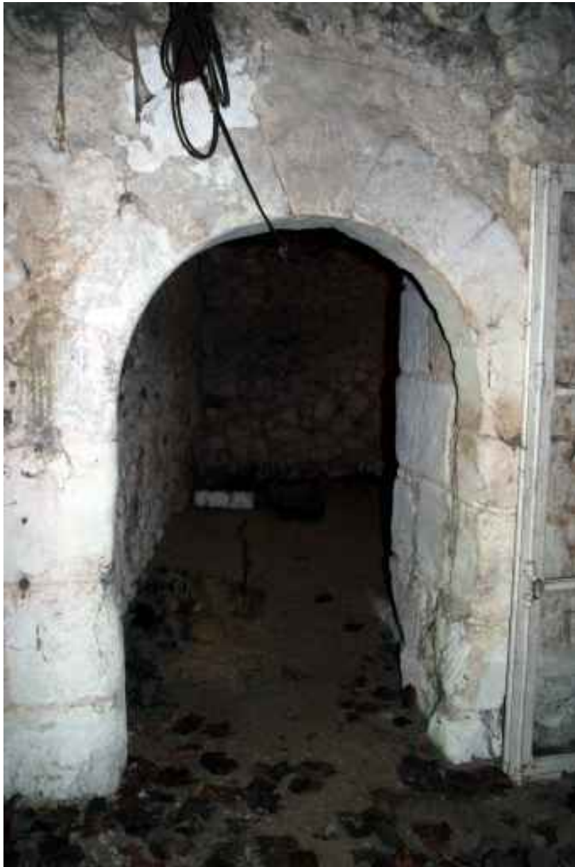
Le cellier : porte d'entrée.
